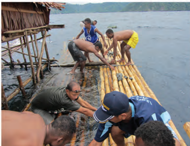
Mengganti rakit yang rusak
